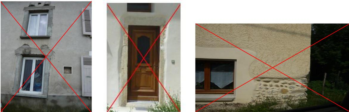
*Des finitions d'enduit interdites car en saillie ou découvrant le soubassement.*
