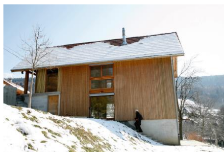
Accès par le haut
